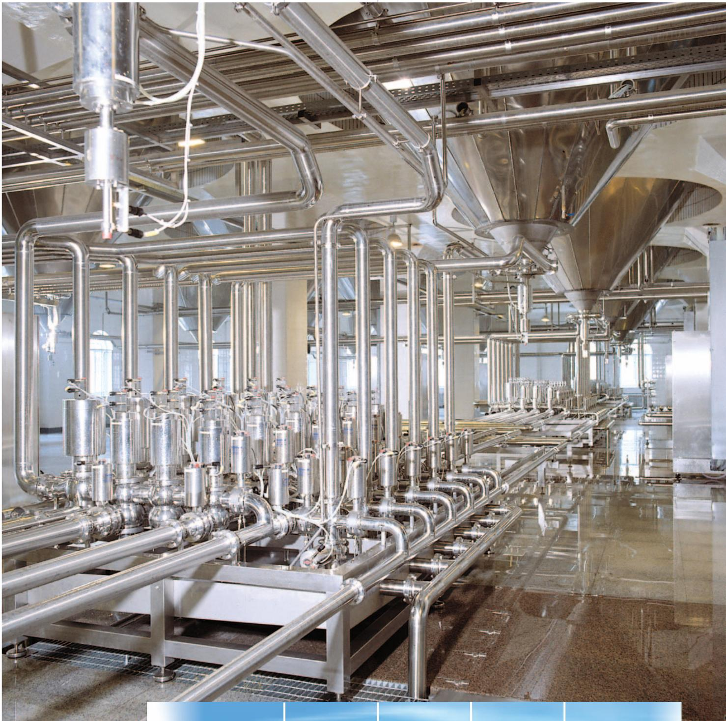
▲ Построенная на двухседельных клапанах и клапанах бабочка с контролем протечки клапанная гребенка полностью автоматизирует процесс наполнения, опорожнения и мойки группы емкостей
